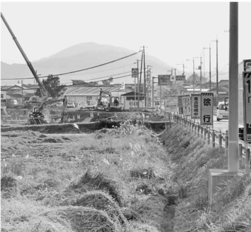
早咲地区よりバイパス工事始まる
