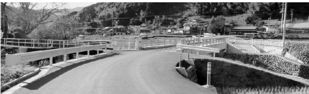
佐賀橋川の高規格工事用道路が整備された。
