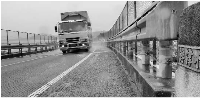
車と路肩の間が通学路となる浮津橋
