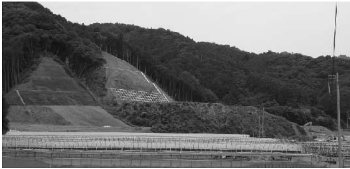
来年完成予定をめざす白石団地工事
