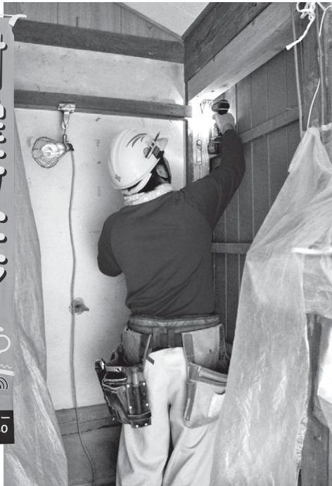
補助を活用した家屋の耐震改修工事。補強材と柱を「柱頭金具」で固定中
