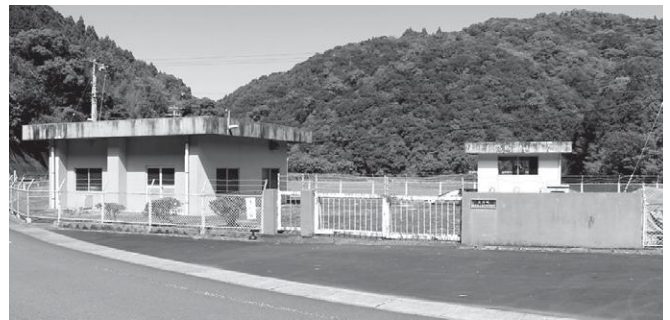
上水道上川口取水施設
