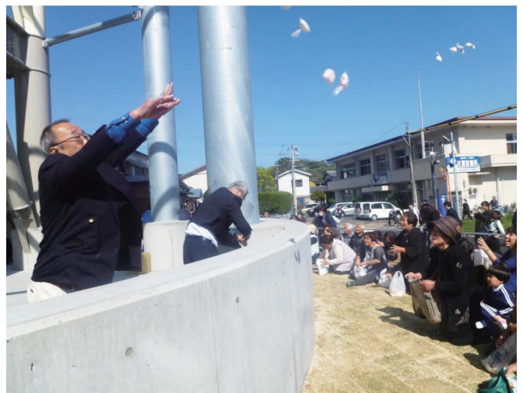
平成29年3月、高さ25m国内最大級の規模で総工費6億円余をかけて建設した「住民の命を守る佐賀避難タワー」の完成を祝ってのお餅投げの一コマ
