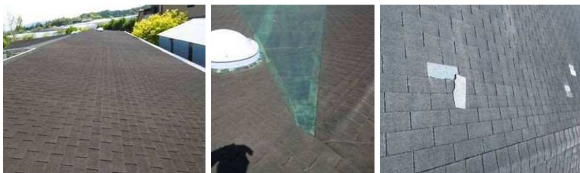
屋根・屋上 劣化がみられるが機能性に問題なし 判定B
