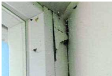
内部仕上げ 劣化が激しく雨漏り、腐敗など様々な問題がある また空調機器が機能していない 判定D
