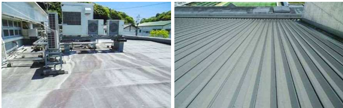
屋根・屋上 問題なし 判定A
