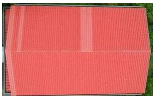
屋根・屋上 劣化がみられるが機能性に問題なし 判定B
