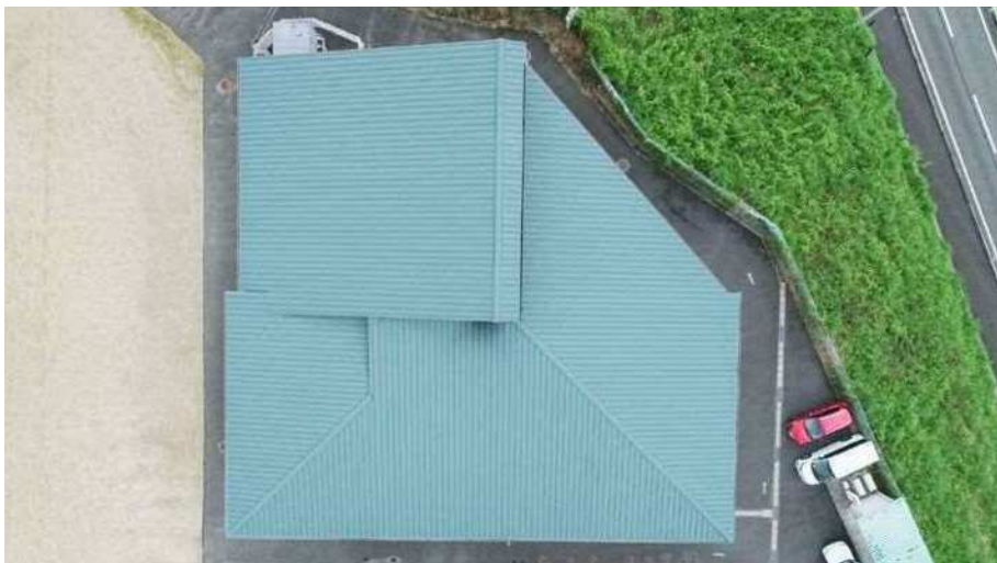
屋根・屋上 問題なし 判定A
