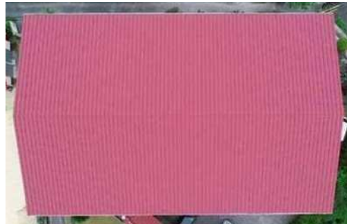
屋根・屋上 問題なし 判定A
