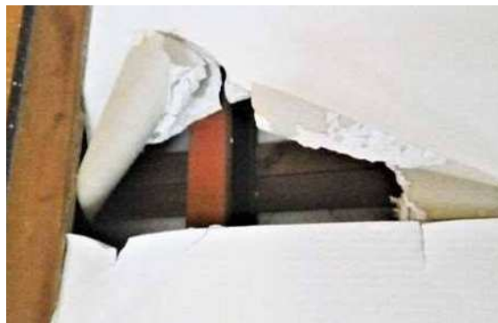
内部仕上げ 劣化が激しく怪我をする恐れがある 判定C
