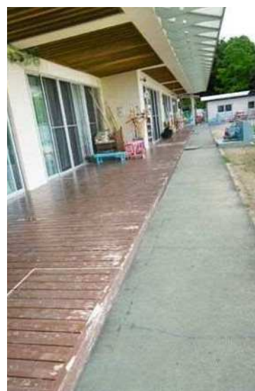
内部仕上げ テラスが腐敗し釘がむき出しで怪我をする恐れがある 判定D
