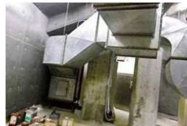
内部仕上げ 劣化が激しく雨漏り、腐敗など様々な問題がある また空調機器が機能していない 判定D
