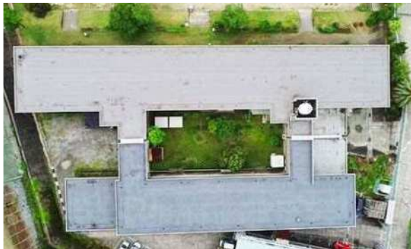
屋根・屋上 問題なし 判定A
