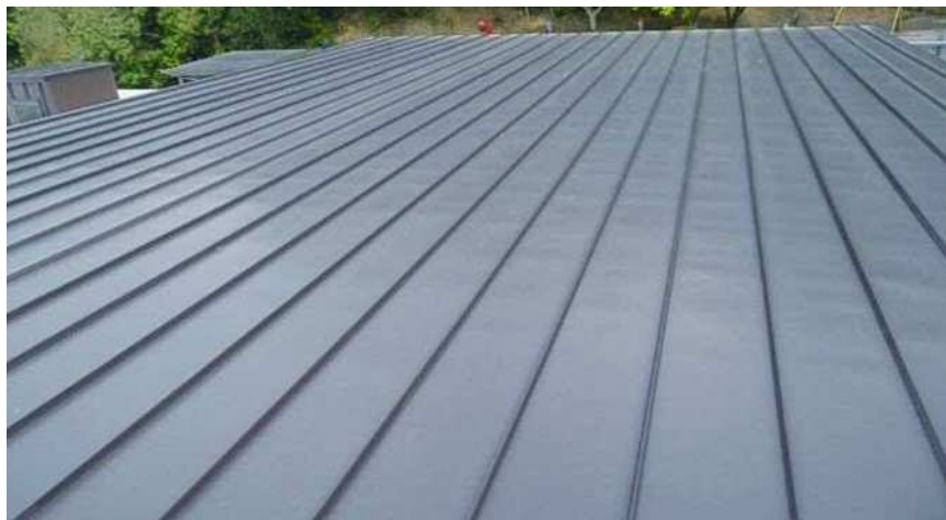
屋根・屋上 問題なし 判定A
