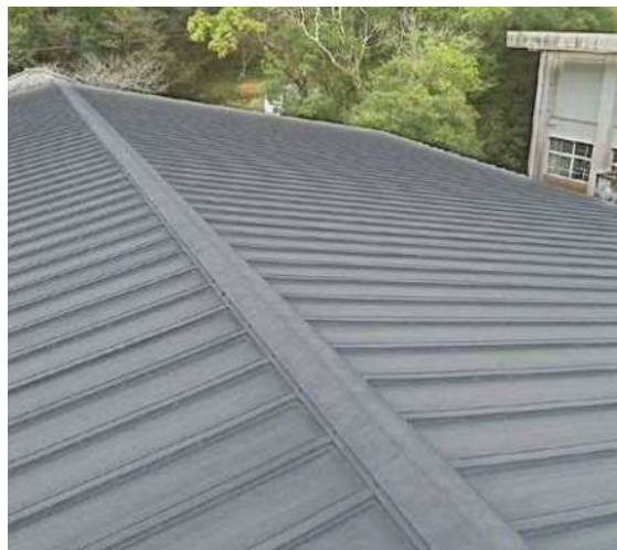
屋根・屋上 劣化がみられるが機能性に問題なし 判定B
