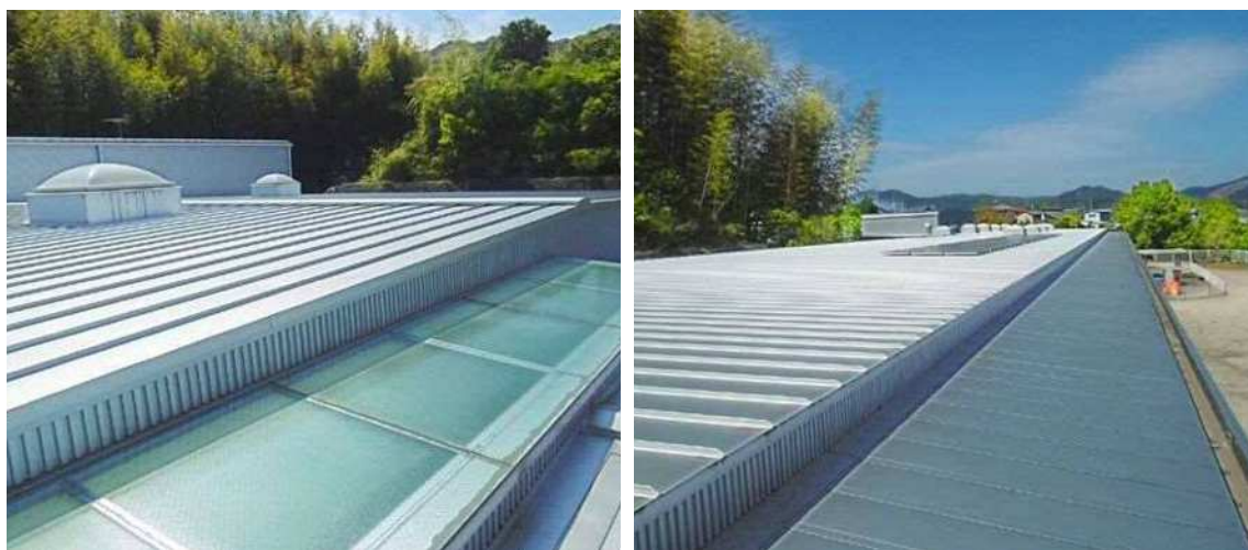
屋根・屋上 問題なし 判定A
