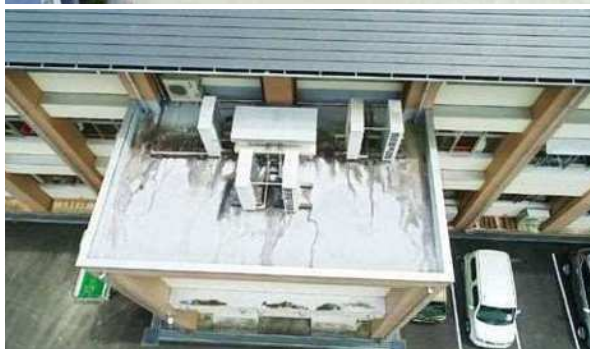
屋根・屋上 問題なし 判定A
