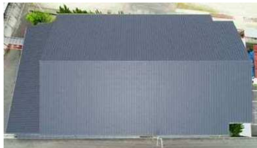
屋根・屋上 問題なし 判定A
