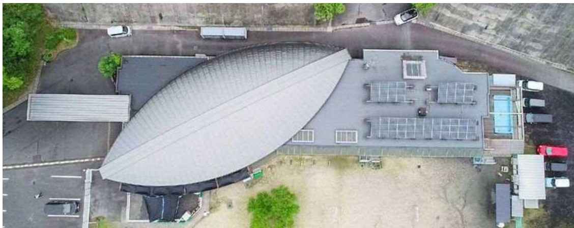
屋根・屋上 問題なし 判定A
