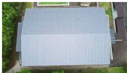
屋根・屋上 問題なし 判定A
