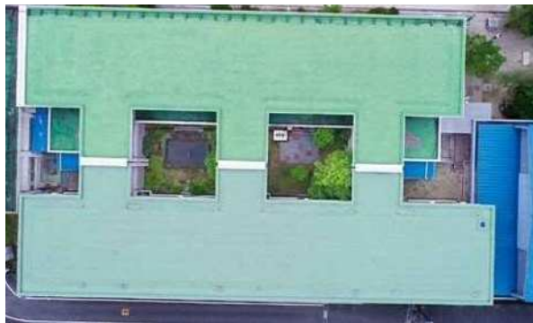
屋根・屋上 問題なし 判定A
