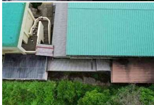
屋根・屋上 問題なし 判定A
