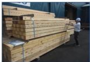
（町産材材料確認）
