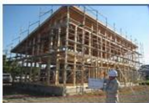
（町産材施工確認）
