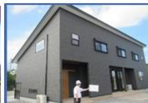
（町産材完成確認）
