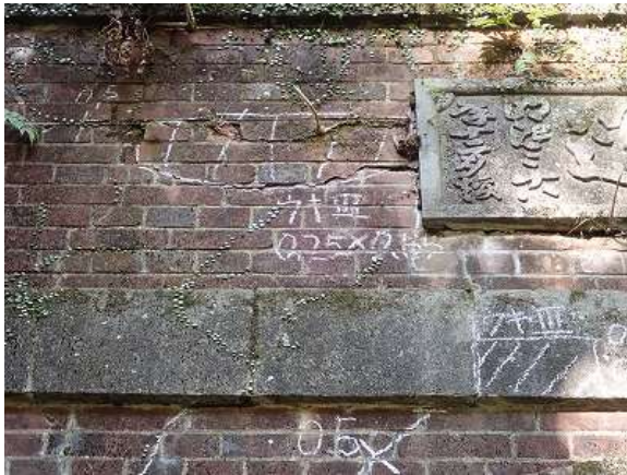
写真 1.2.1 ひび割れでブロック化したレンガのはく落懸念箇所
