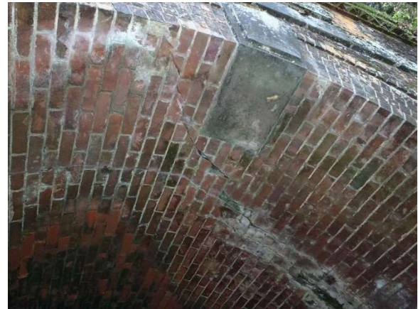
写真 1.2.1 ひび割れでブロック化したレンガのはく落懸念箇所
