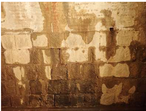
写真 1.2.2 側壁の石積みとアーチからの漏水と路面の滞水状況
