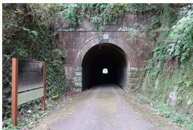
町道中角熊井線 熊井隧道
