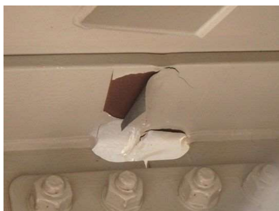
軽微な腐食と塗膜のはがれ
