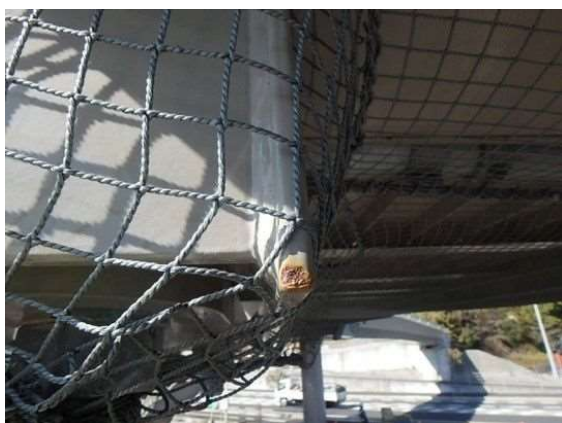
軽微な腐食と塗膜のはがれ
