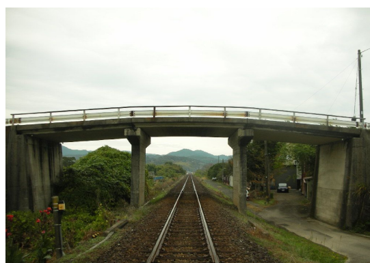
鉄道を跨ぐ橋の事例
