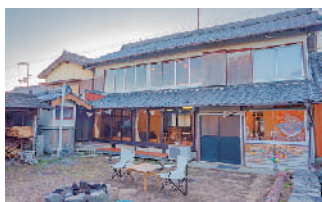
古民家を改修した宿泊施設
