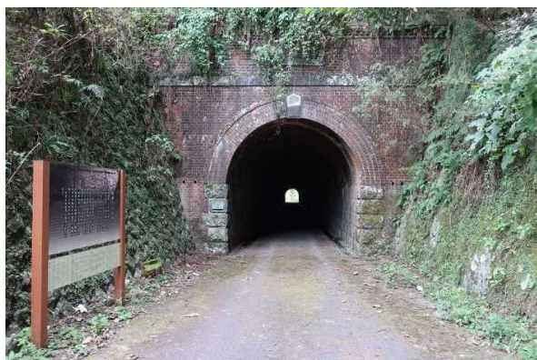
町道中角熊井線 熊井隧道
