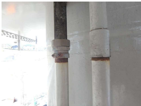
排水管の腐食と舗装コンクリートの遊離石灰
