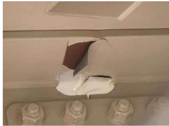
軽微な腐食と塗膜のはがれ
