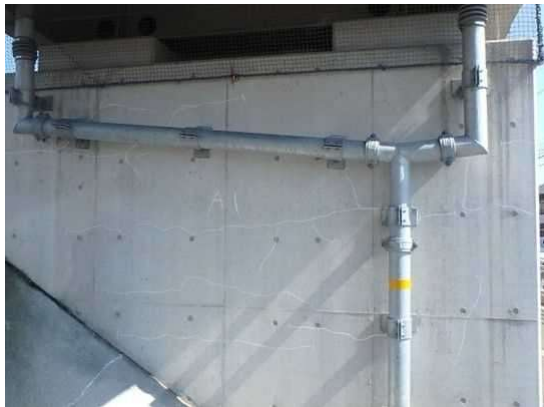
コンクリート部材の軽微なひびわれ
