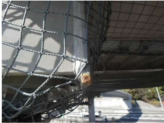
軽微な腐食と塗膜のはがれ
