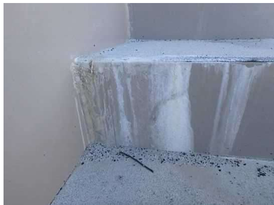
排水管の腐食と舗装コンクリートの遊離石灰
