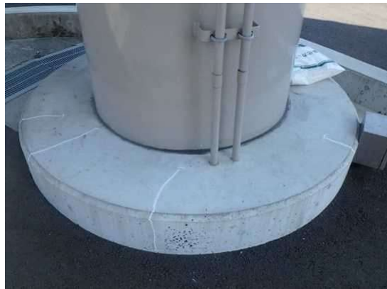
コンクリート部材の軽微なひびわれ
