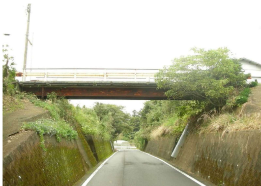
道路を跨ぐ橋の事例
