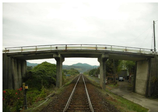
鉄道を跨ぐ橋の事例
