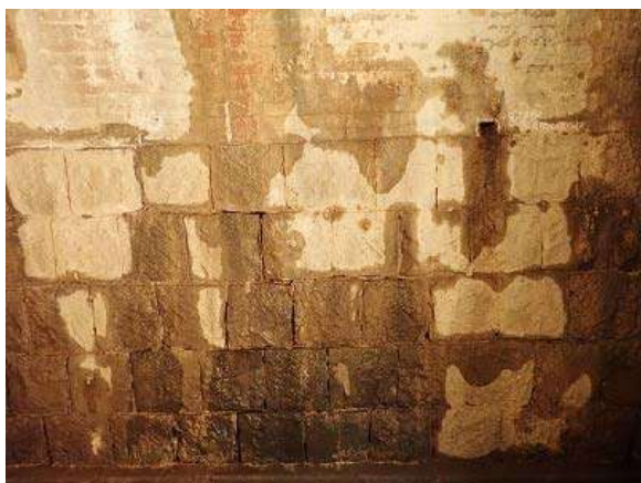
写真 1.2.2 側壁の石積みとアーチからの漏水と路面の滞水状況
