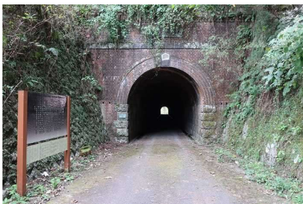
町道中角熊井線 熊井隧道
