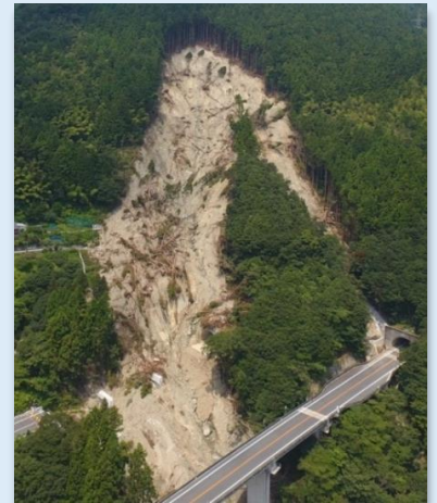
大豊町で発生した山腹崩壊 (平成30年7月撮影)
