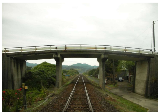
鉄道を跨ぐ橋の事例
