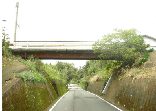
道路を跨ぐ橋の事例
