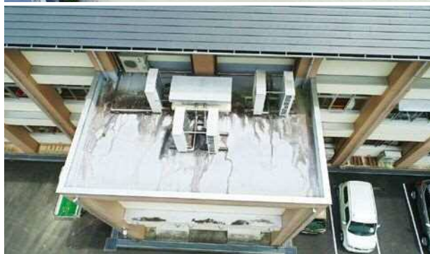
屋根・屋上 問題なし 判定A
