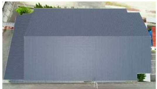
屋根・屋上 問題なし 判定A
