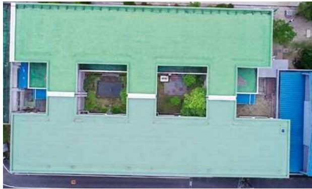
屋根・屋上 問題なし 判定A
