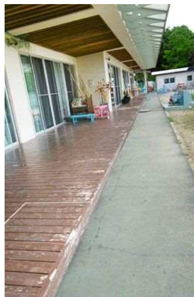
内部仕上げ テラスが腐敗し釘がむき出しで怪我をする恐れがある 判定D
