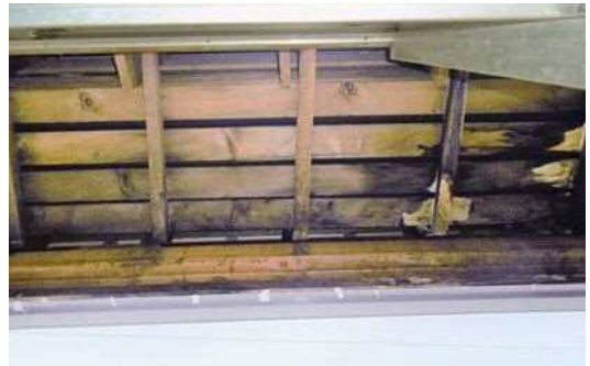
屋根・屋上 劣化がみられるが機能性に問題なし 判定B
