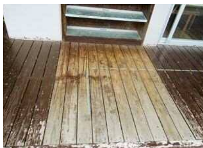
内部仕上げ テラスが腐敗し釘がむき出しで怪我をする恐れがある 判定D
