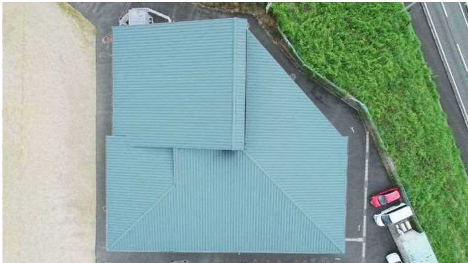
屋根・屋上 問題なし 判定A
