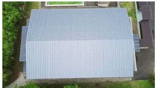
屋根・屋上 問題なし 判定A
