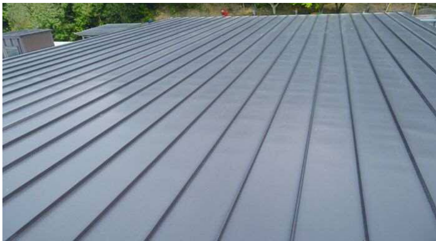
屋根・屋上 問題なし 判定A
