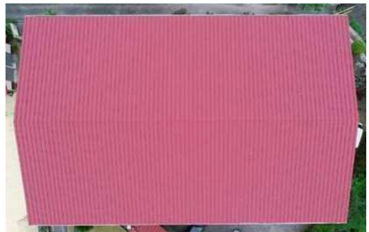
屋根・屋上 問題なし 判定A
