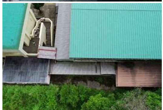
屋根・屋上 問題なし 判定A
