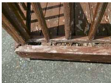
内部仕上げ テラスが腐敗し釘がむき出しで怪我をする恐れがある 判定D
