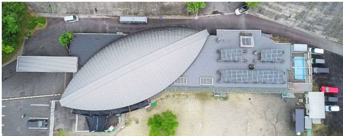
屋根・屋上 問題なし 判定A
