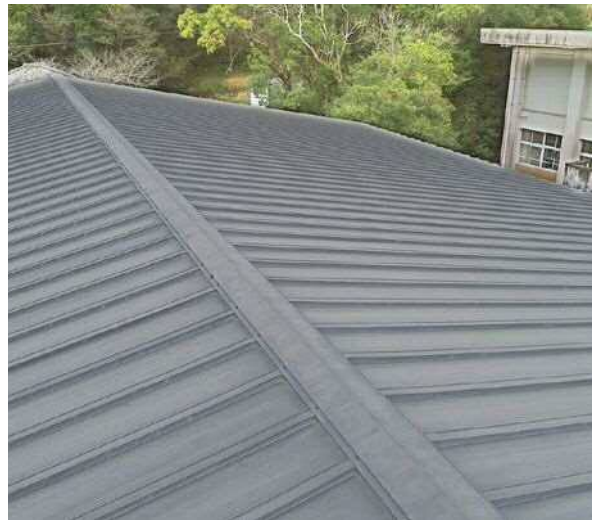
屋根・屋上 劣化がみられるが機能性に問題なし 判定B
