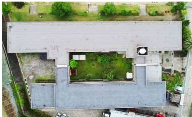
屋根・屋上 問題なし 判定A
