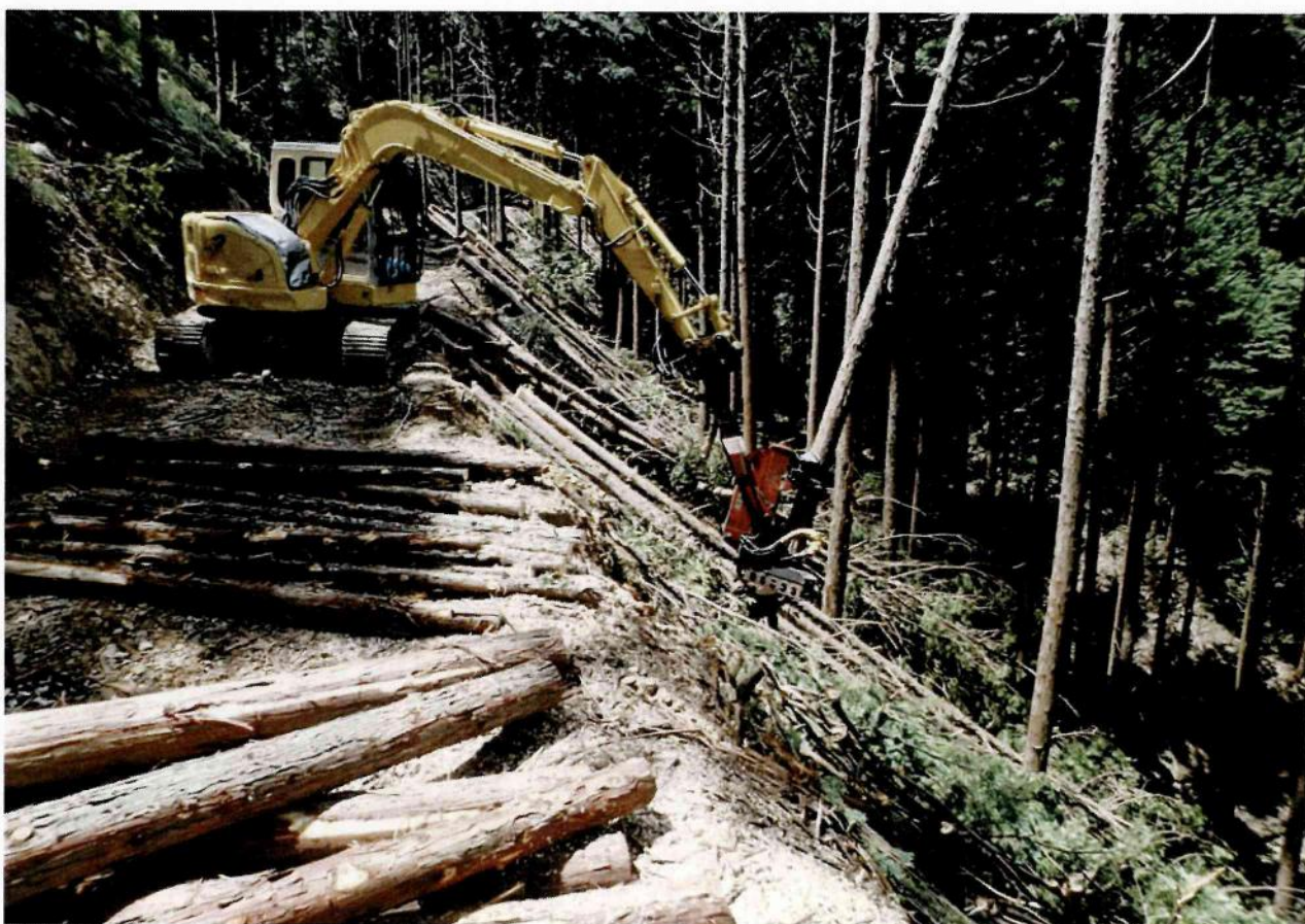
高性能林業機械を使って造材(伐倒した木を必要な長さに切る)していきます。
