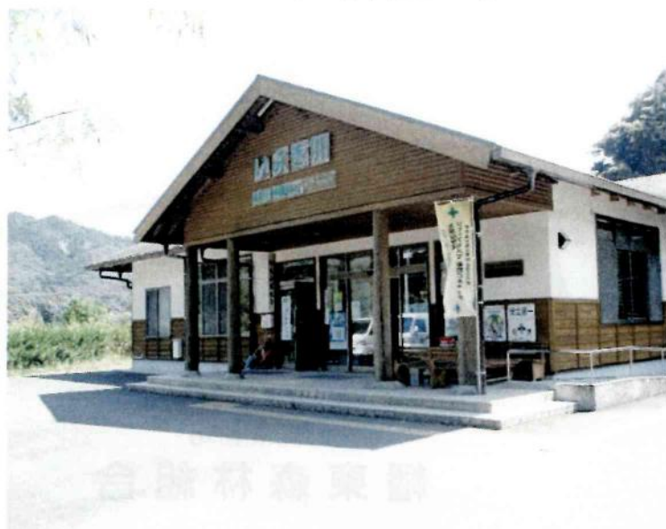
森林組合事務所／黒潮町林業総合センター
