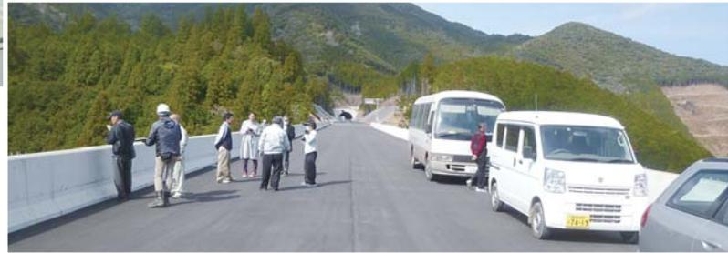
▼ドローンの実演中です。高架橋上の舗装は縦溝の排水のよい構造です(佐賀橋川)
