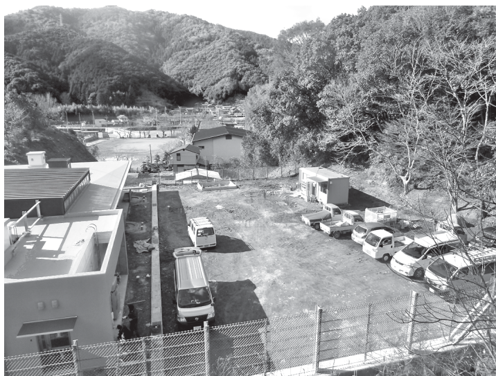
新築工事が進む新佐賀保育所（仮称）。写真中央部には伊与喜小学校の体育館が、その奥側には伊与喜地区の集落が望める（1月13日）
