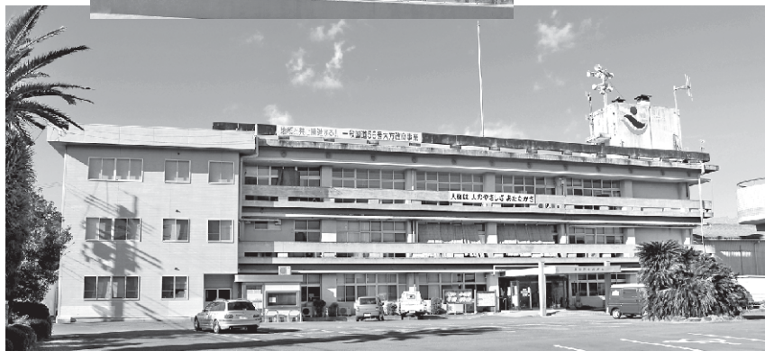
庁舎の高台移転に伴い解体される旧庁舎（1月3日）
