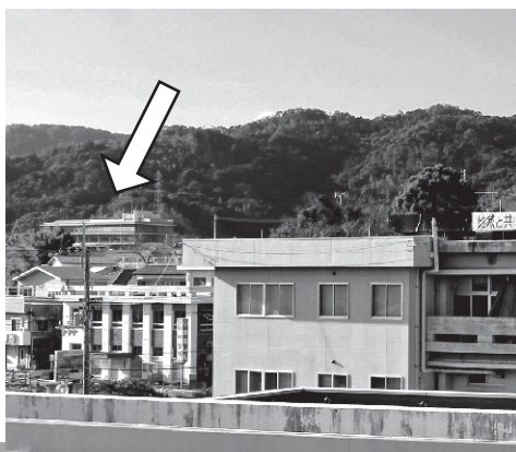
手前中央の旧庁舎（こしに新庁舎（矢印先）が（保健福祉センター屋上より）
