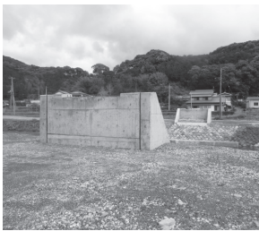
工事中の法寿院橋 (有井川)
