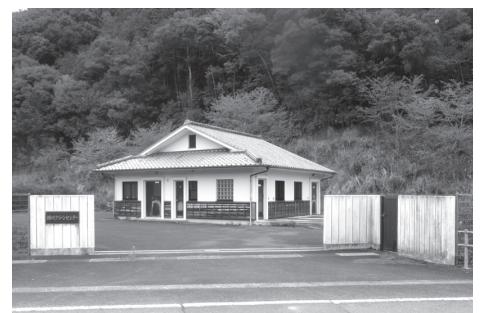
蛭川クリーンセンター（農業集落排水事業）
