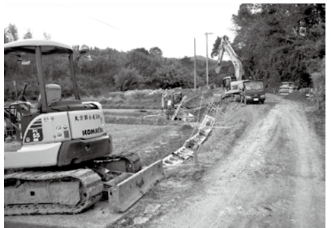
工事が進む町道下風深線（H27年1月5日）
