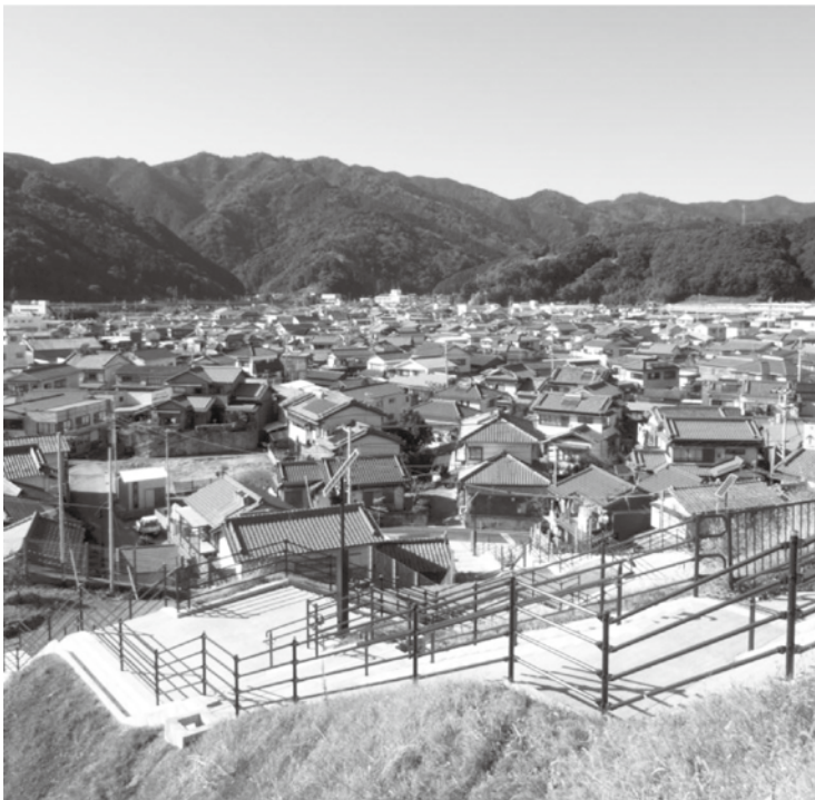
津波避難タワー建設予定の佐賀地区
