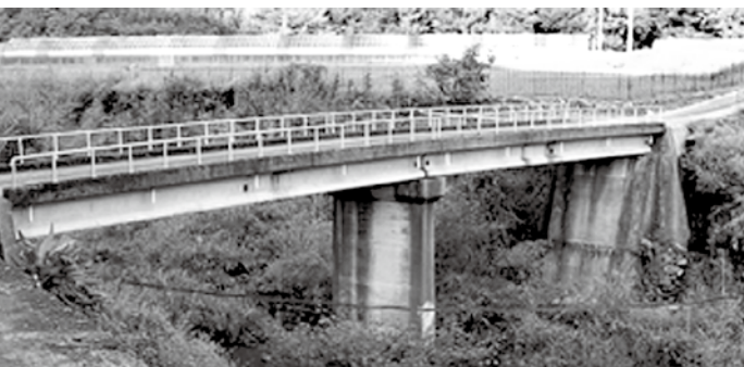
拳ノ川の橋梁
