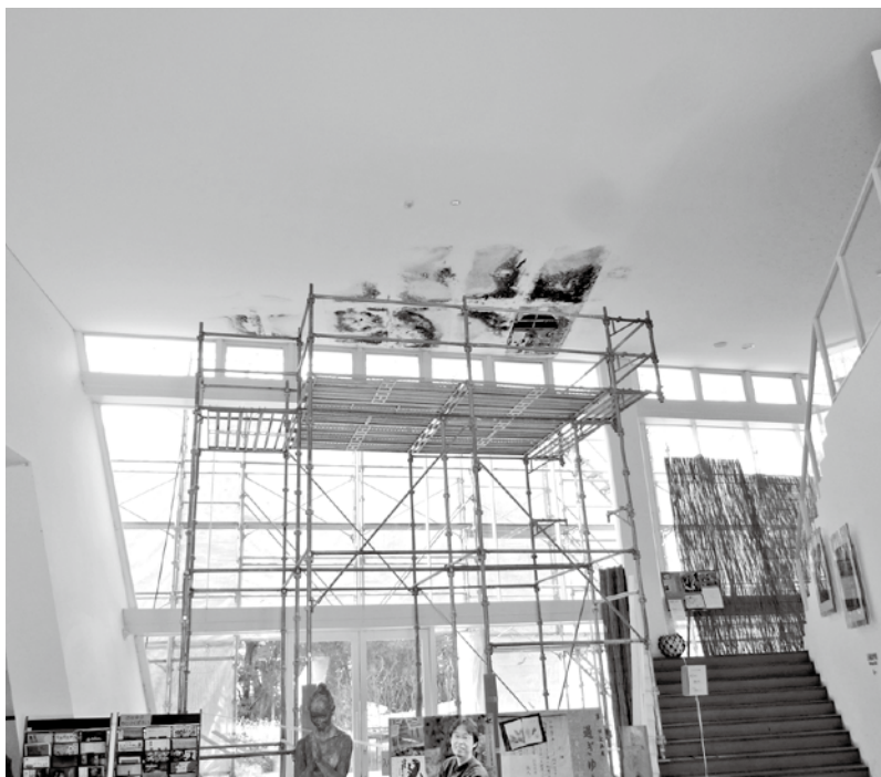
工事中のエントランスホール
