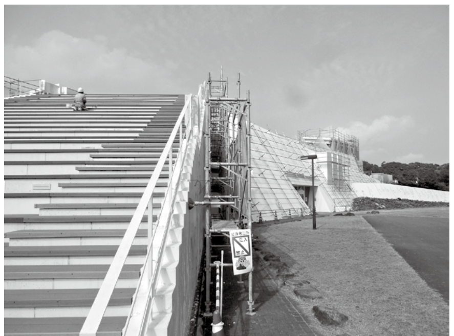
防水等の工事が始まった大方あかつき館
