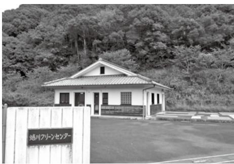
蜷川クリーンセンター
