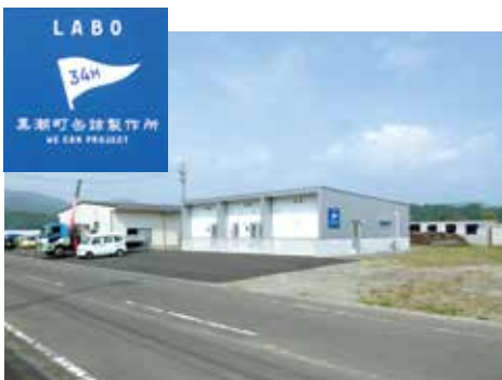
稼働中の缶詰工場（早咲）
