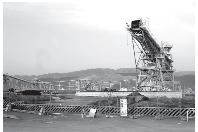
高台への宅地造成（中央奥側）と浸水被災した市街地のかさ上げのため何通りにも設置されたベルトコンベア群。ダンパー使用より工期が早いとのことだが、それでもかさ上げにはまだ2～3年は要するとのこと。（陸前高田市：H26年5月14日議員研修にて）
