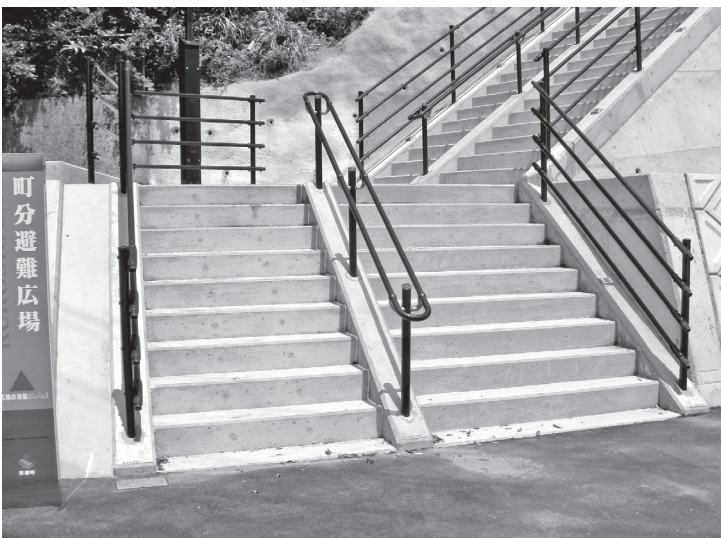
完成した町分避難道
