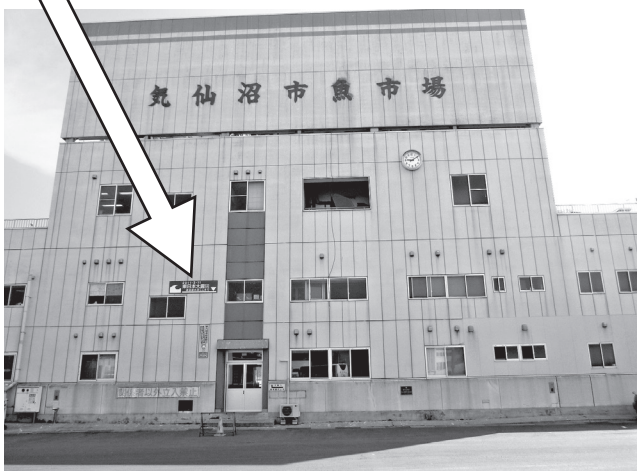
2階まで浸水した気仙沼市魚市場、幸い骨組みが残ったので復旧が比較的に早かったとのこと
