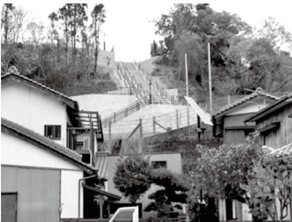
佐賀地区城山への避難階段工事進行中
