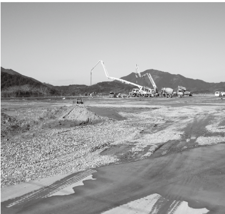
ペレット工場建設現場（宿毛市平田の工業団地内）
