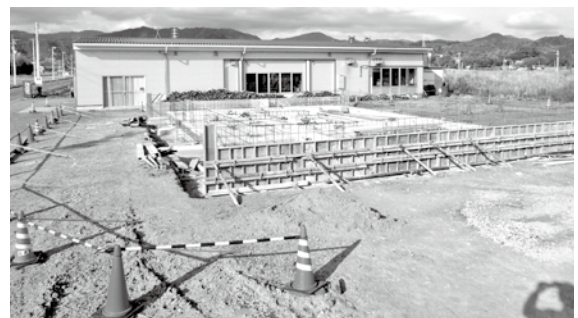
建設が始まった缶詰工場（入野早咲地区）
