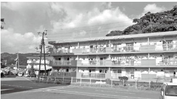
町営住宅 (上：拳ノ川若者定住、下：明神第二住宅)
