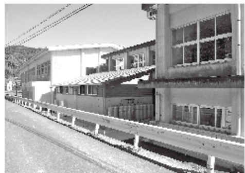
センター内の風呂場 (中央平屋)
