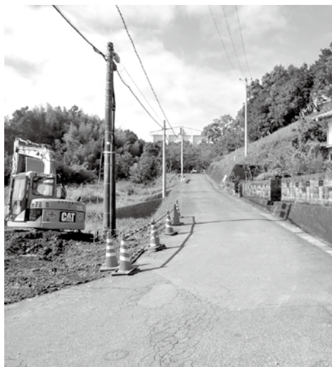
整備の進む町道田端線（入野）
