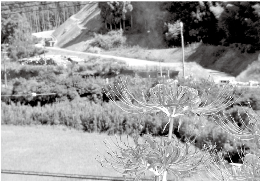
「自動車道 東に迎え 彼岸花」 (拳の川の自動車専用道に向かうための工所用道路)
