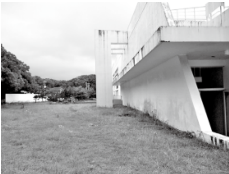
避難タワー建設予定地（大方あかつき館裏）
