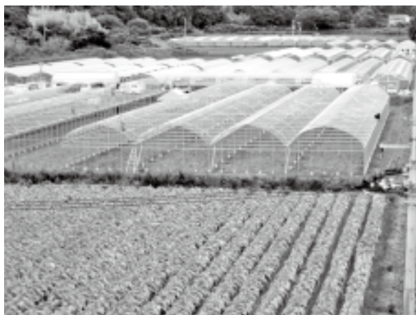
建設が始まった研修ハウス (浮鞭)
