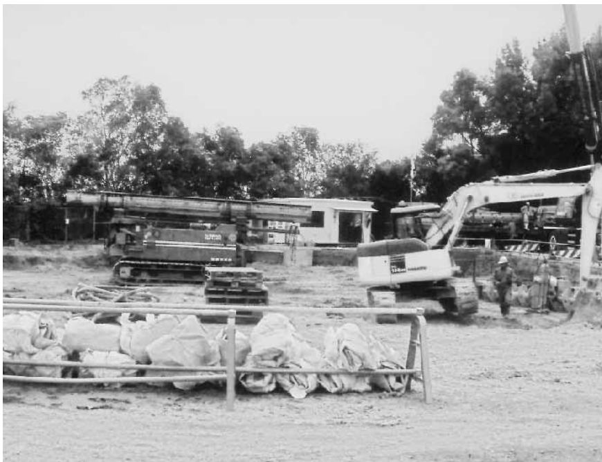
大方地区給食センター工事始まる（大方中学校校庭）
