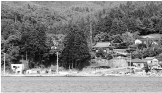
電柱1本分の高さで津波被害を逃れた家屋（宮城県気仙沼港）
