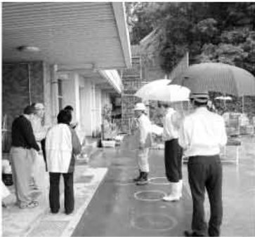
伊田小学校、外から工事現場を見る
