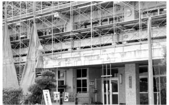
佐賀小耐震工事中
