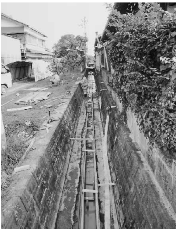
錦団地の部落事業(排水路改修)
