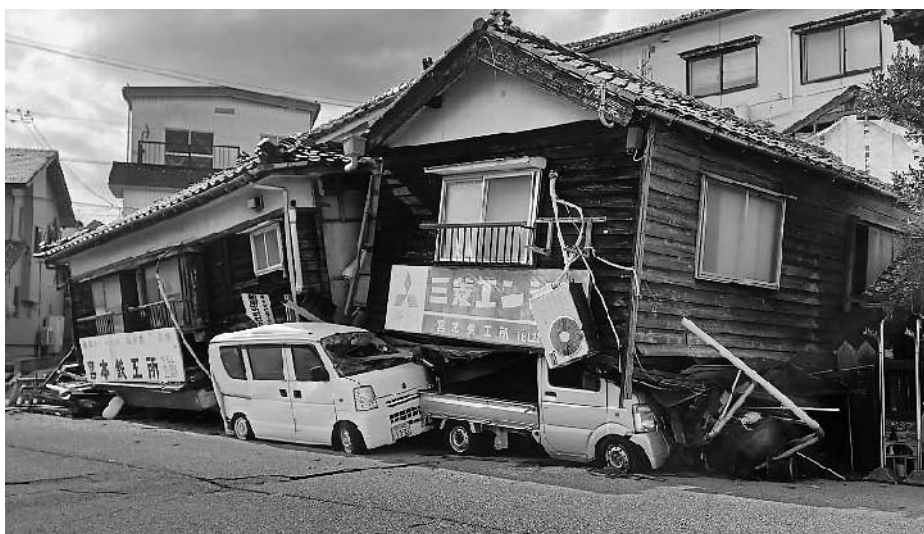
輪島市の建物被害
