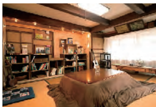
改修中の古民家の様子
